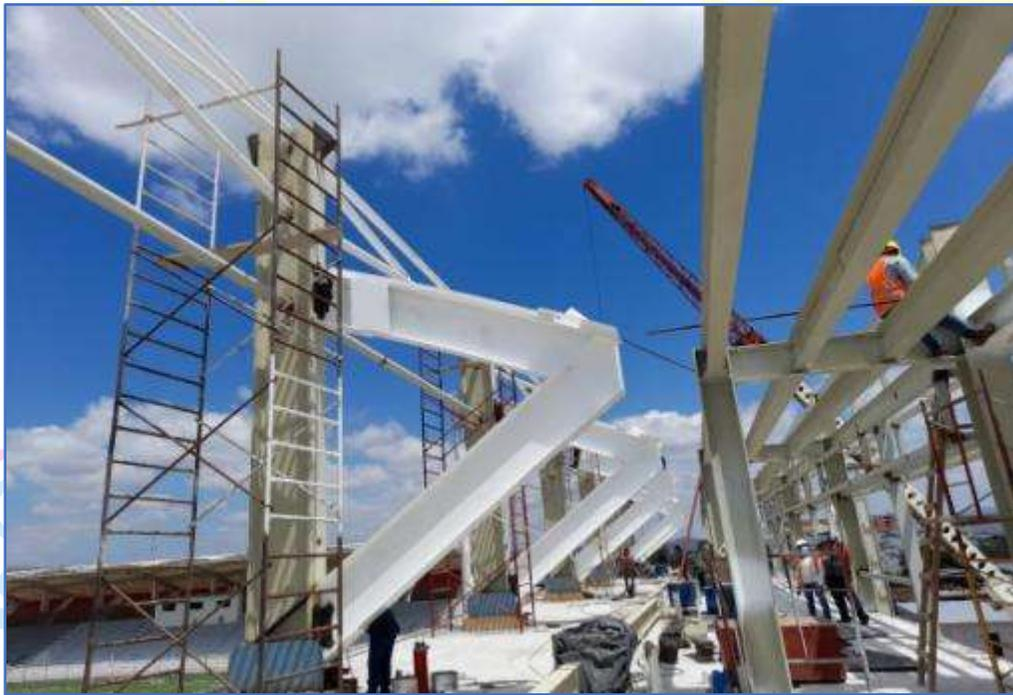
Armado y soldado de estructura para techo. Elementos articulados.
