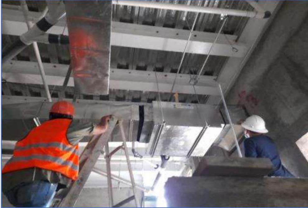
Canalizaciones electricas, tubería hidrosanitaria, canastas para cableado de sistemas de voz y datos, ducto de climatización.
