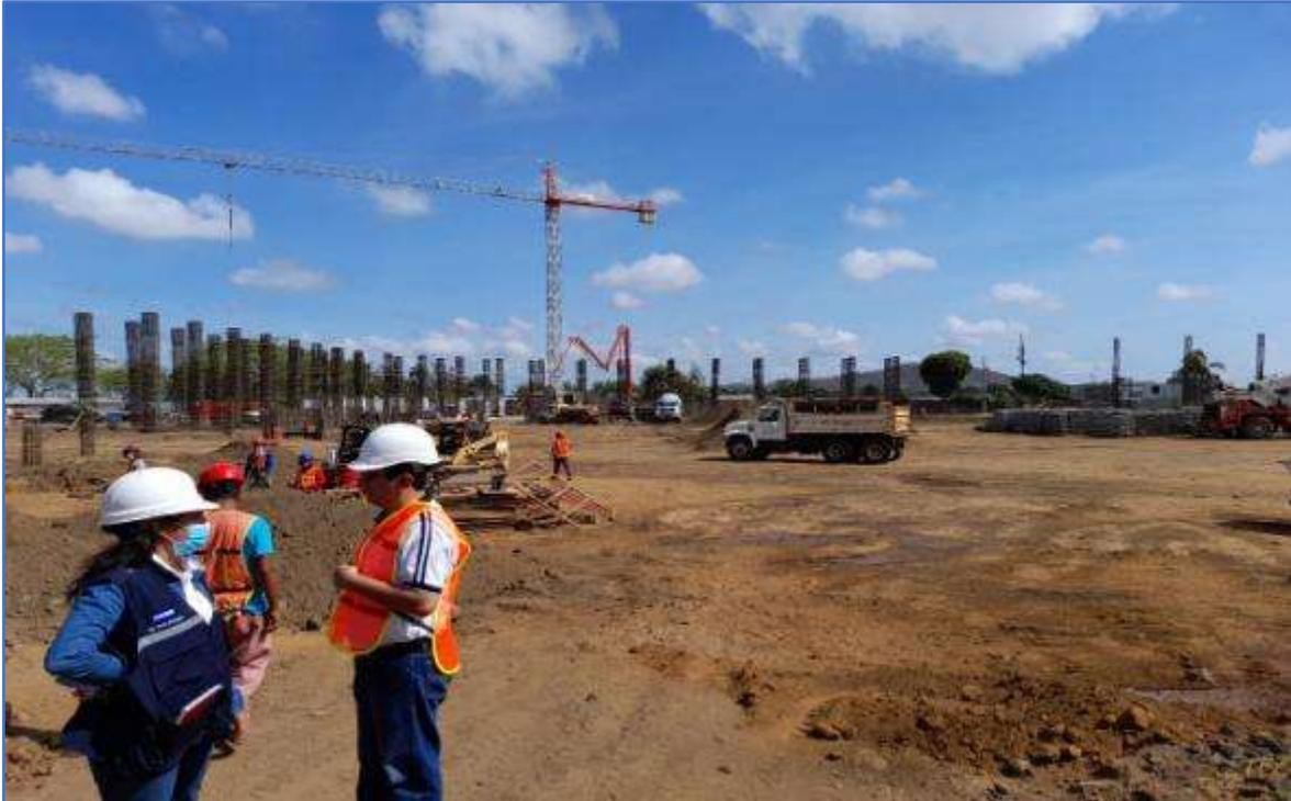
Sector norte. Cimentación finalizada, acero de refuerzo para columnas de concreto erigidas.
