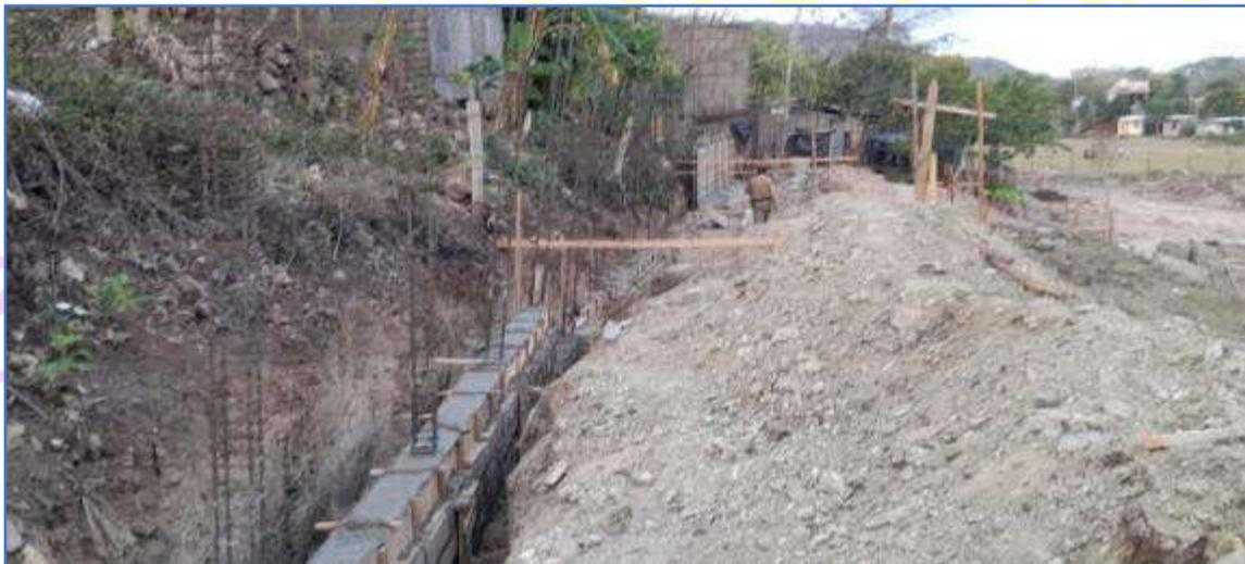
Foto mostrando viga asísmica y muro de fundacion en area del norte del terreno.
