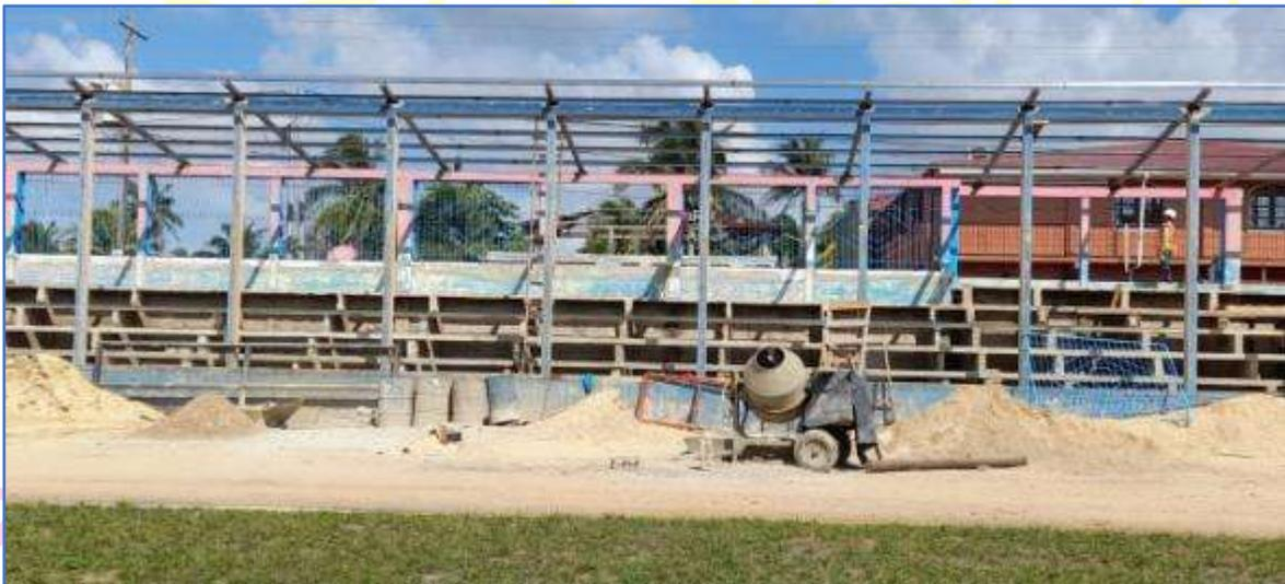
Fotos mostrando las graderías con la estructura metálica y cubierta de techo instaladas.
