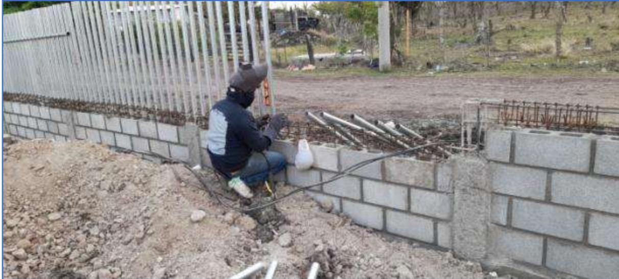
Instalando tubos galvanizados en muro fachada.
